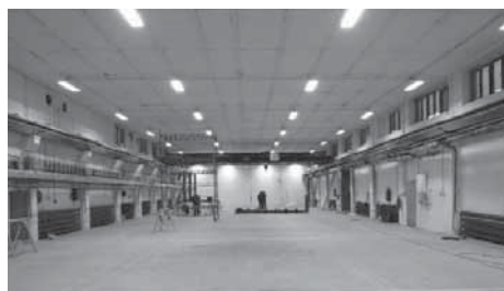
Horní dílna - nová střecha, podlaha a LED osvětlení
