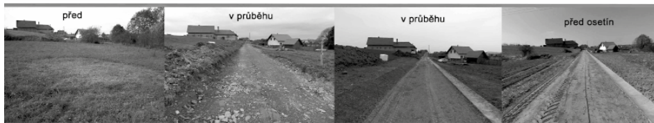
JPÚ Hrachovec - vybudování polní nezapevněné cesty s odvodňovacím žlabem a zatravněným krytem.
