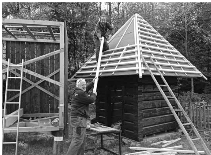
Laťování střechy orloje, 30. 9. 2021
