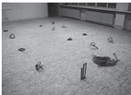
Elektrorozvody do lavic
