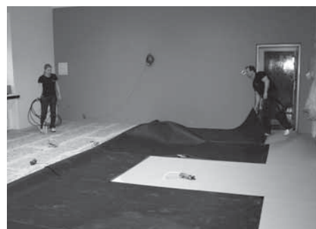
Pokládka nové podlahy
