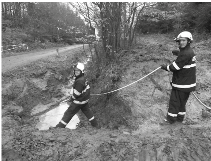
Čištění propustku na Nové cestě, 12. 1. 2023
