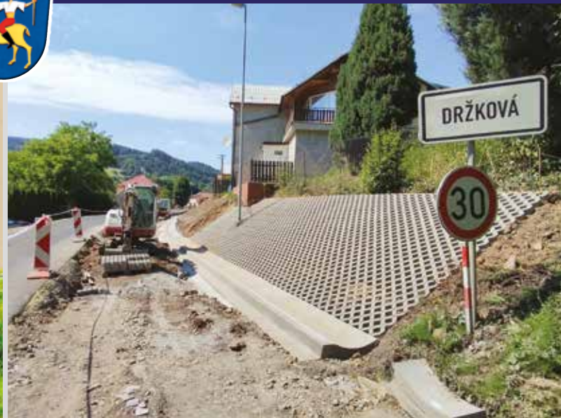
Rekonstrukce silnice v Držkové, 3. 7. 2025
